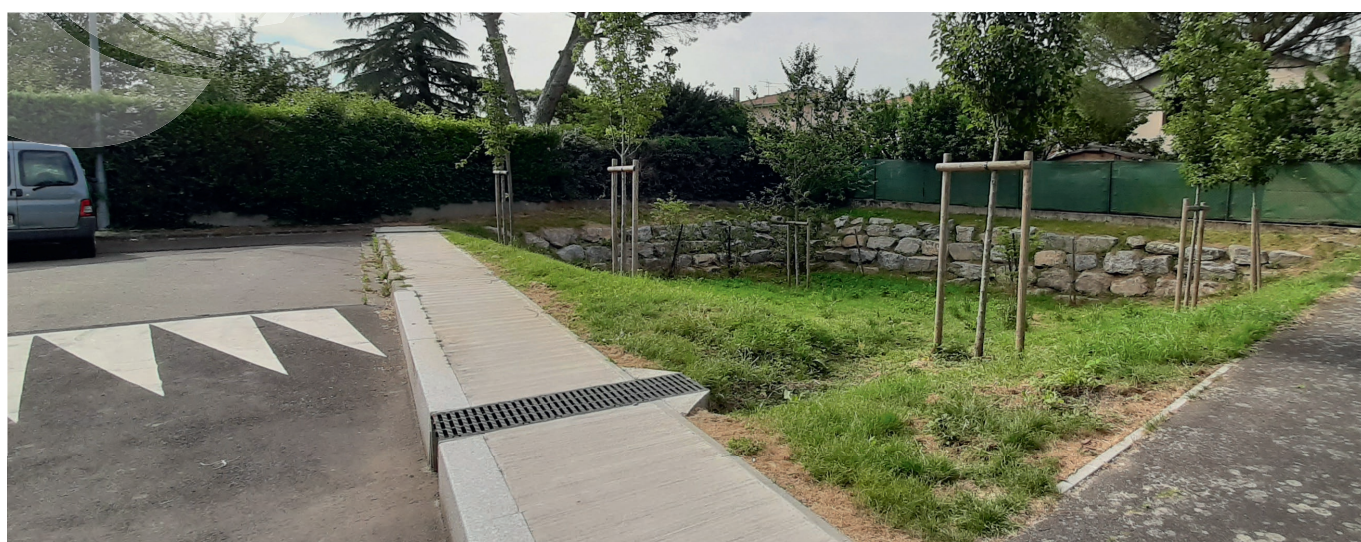
Déconnexions des réseaux et gestion intégrées des eaux pluviales permettent de mieux faire face aux pluies exceptionnelles à Portet-sur-Garonne. ▲
